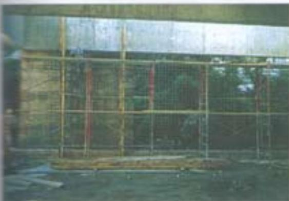
*Encofrado de tabiques perimetrales (hormigón gunitado), que serán del tipo "muro ventilado".*
