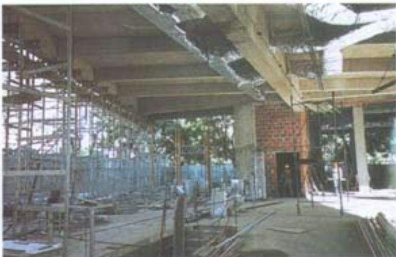
Instalación de conductos de aire acondicionado en PB. Vista de los que vuela 25 m sobre hall de entrada, y de sus apuntalamientos.
